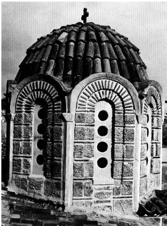
Εικ. 3. Ο τρούλος μετά τις εργασίες αποκατάστασης.
