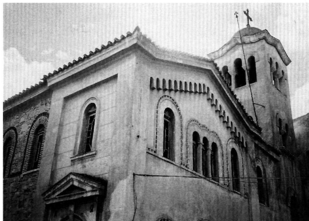
Εικ. 4. Η βορειοδυτική γωνία και το κωδωνοστάσιο της μεταγενέστερης φάσης.
