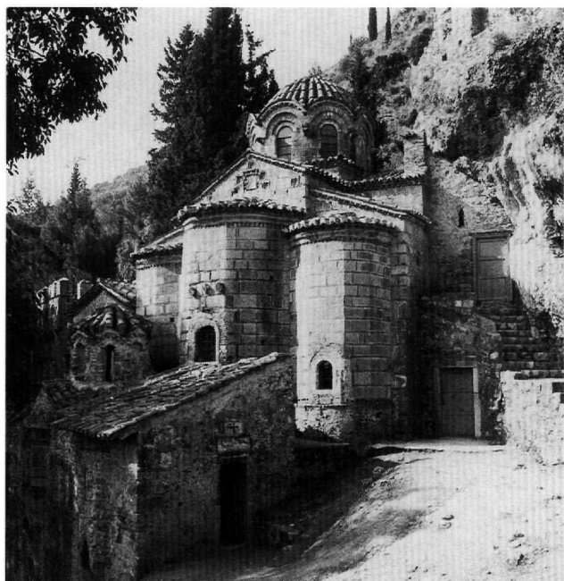
Εικ. 20. Ανατολική πλευρά του ναού. Διακρίνεται η απολαξευμένη πλάκα στο μέτωπο της κεραιάς του σταυρού.
