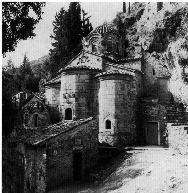
Εικ. 20. Ανατολική πλευρά του ναού. Διακρίνεται η απολαξευμένη πλάκα στο μέτωπο της κεραίας του σταυρού.
