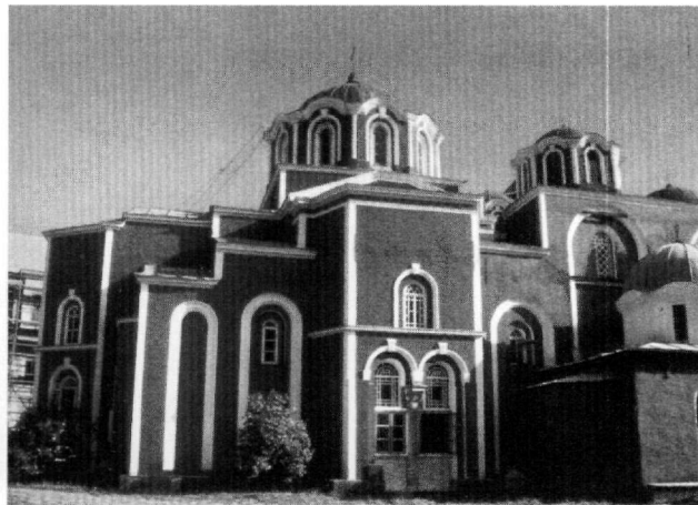
Εικ. 2. Καθολικό μονής Ιβήρων. Άποψη από τα βόρεια.
