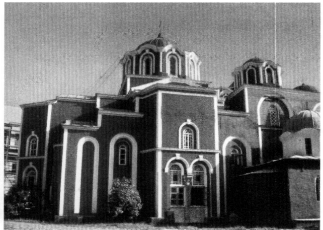
Εικ. 2. Καθολικό μονής Ιβήρων. Άποψη από τα βόρεια.
