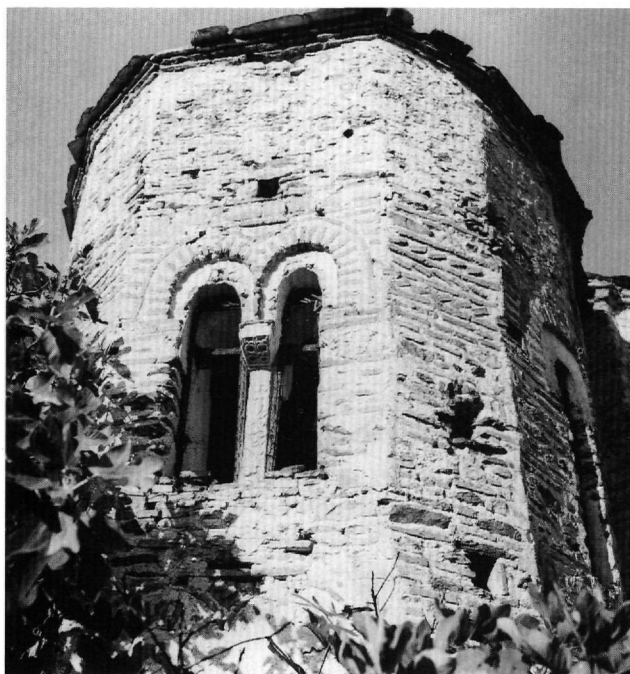
Fig. 5. Drenovo. Chiesa della Vergine. Abside dell'altare. Condizione attuale.
