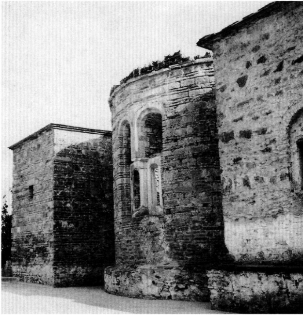
Εικ. 9. Καθολικό μονής Αγίου Δημητρίου Στομίον. Μερική άποψη της βορείας πλευράς.
