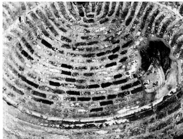
Εικ. 17. Καθολικό μονής Αγίου Δημητρίου Στομίου. Θολοδομία κόγχης στό βόρειο τυπικαριό.
