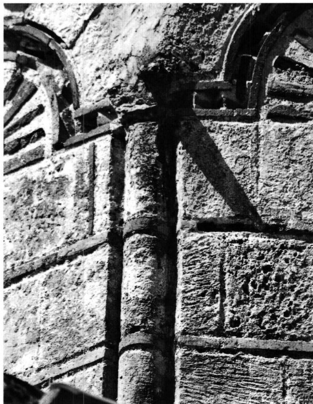
Εικ. 14. Ταξιάρχες στο Λαρίσι Σοφικού. Κιονίσκος τρούλου στη συμβολή της νότιας με τη νοτιοανατολική πλευρά του τυμπάνου, λεπτομέρεια.
