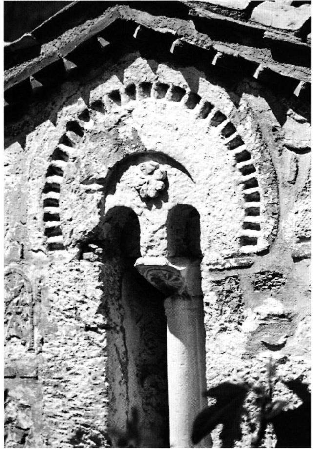
Εικ. 12. Κοίμηση Σοφικού. Το δίλοβο παράθυρο της νότιας πλευράς, λεπτομέρεια.
