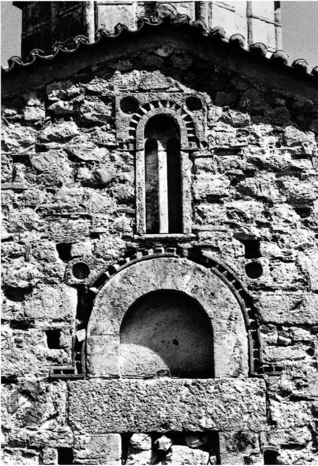
Εικ. 11. Ταξιάρχες στο Λαρίσι Σοφικού. Λεπτομέρεια της δυτικής πλευράς.
