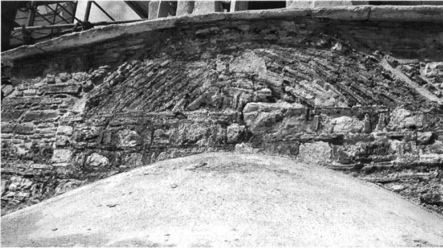
Εικ. 8. Τμήμα τοιχοποιίας πάνω από τη νότια κόγχη του εξωνάρθηκα.
