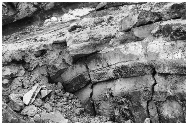
Εικ. 9. Λεπτομέρεια της μεσαιάς τοξωτής απόληξης της δυτικής όψης του εξωνάρθηκα.
