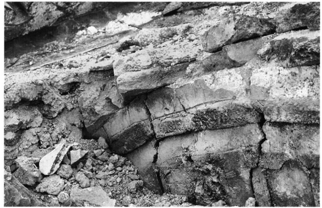
Εικ. 9. Λεπτομέρεια της μεσαιάς τοξωτής απόληξης της δυτικής όψης του εξωνάρθηκα.
