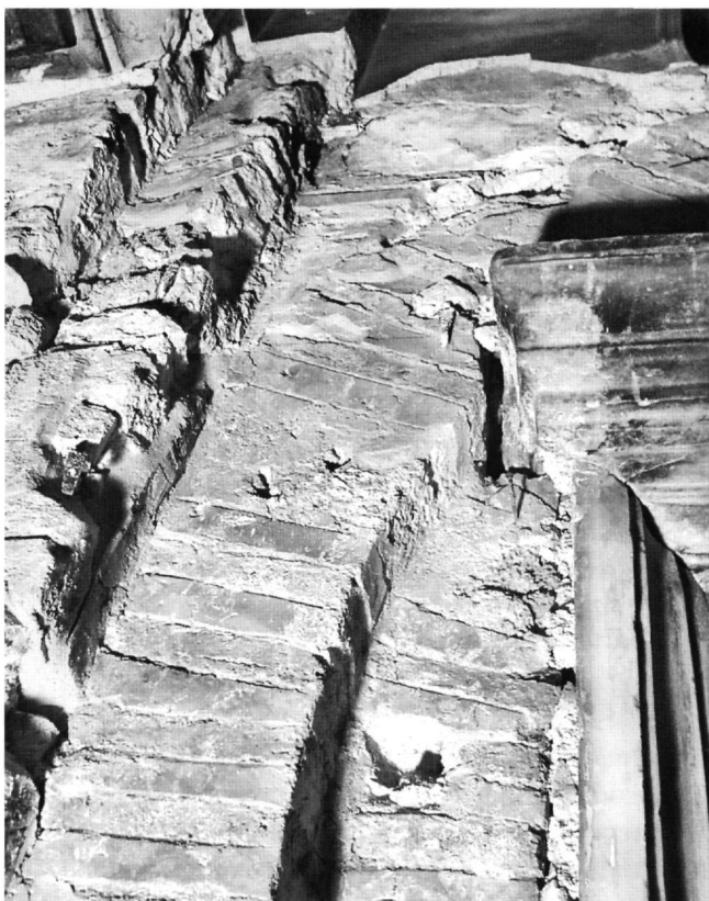
Εικ. 5. Πύλη εισόδου προς τον εσωνάρθηκα, αρχικά αρμολογήματα.
