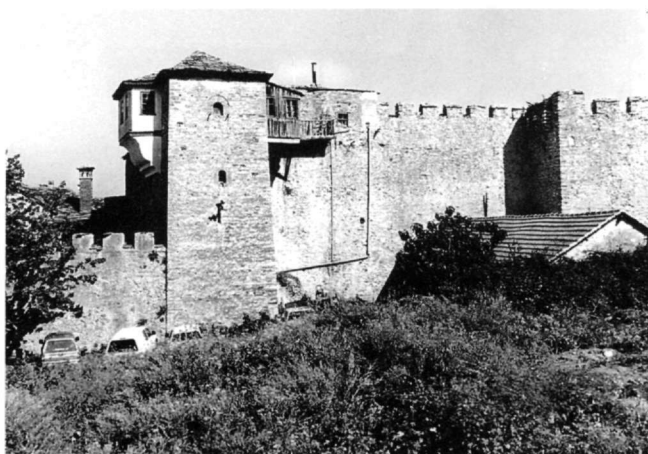
Εικ. 17. Δυτική όψη του πύργου του Νικηφόρου.
