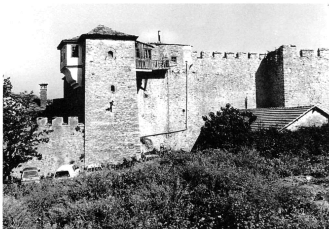
Εικ. 17. Δυτική όψη του πύργου του Νικηφόρου.
