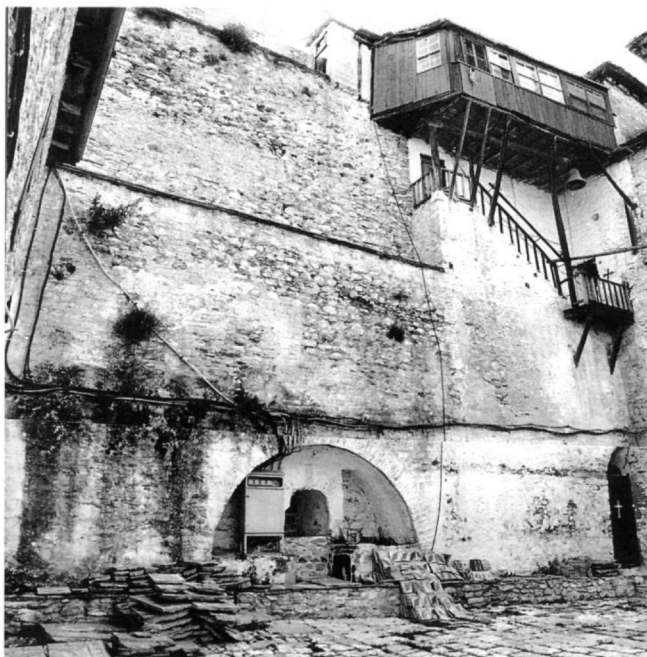
Εικ. 20. Εσωτερική όψη του δυτικού καστρότοιχου.
