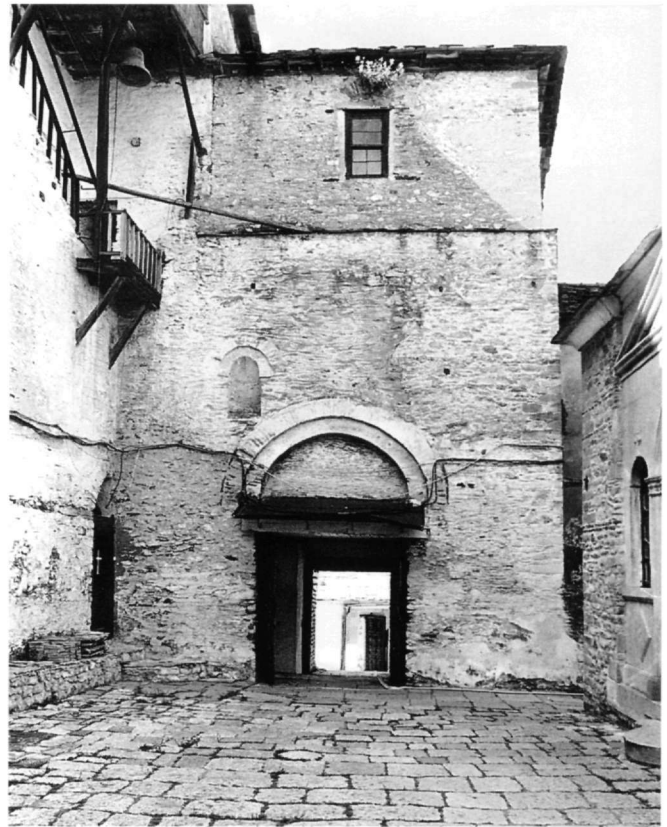
Εικ. 16. Εσωτερική όψη του πύργου της Κοιμήσεως.
