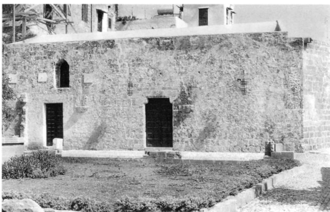
Εικ. 6. Το καθολικό από Ν. μετά τις εργασίες αποκατάστασης και διαμόρφωσης (1999).
