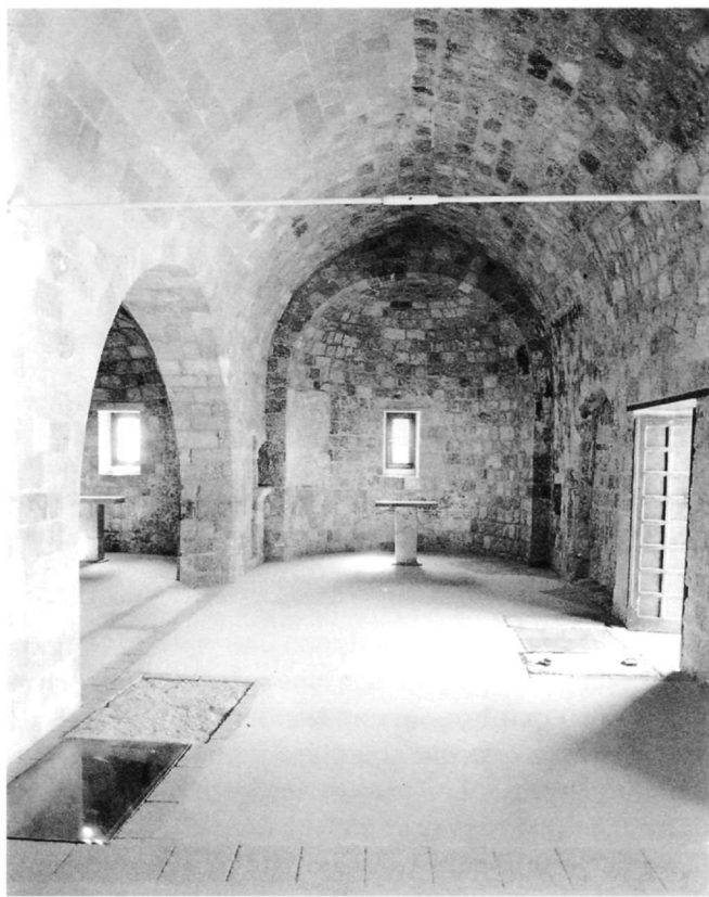
Εικ. 5. Το εσωτερικό του νότιου κλίτους μετά τις εργασίες αποκατάστασης (1999).
