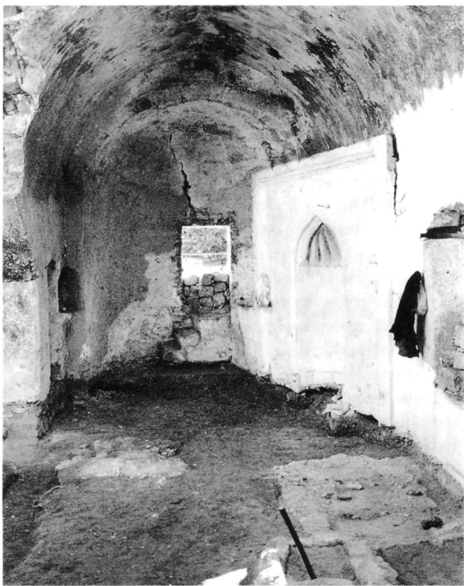
Εικ. 4. Το εσωτερικό του νότιου κλίτους πριν από την αποκατάσταση (1986).
