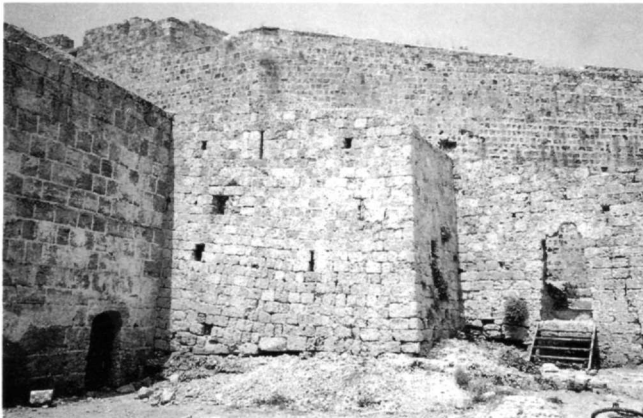
Εικ. 12. Γωνία μεσαιωνικής οχύρωσης στα βόρεια του προμαχώνα του Carretto.
