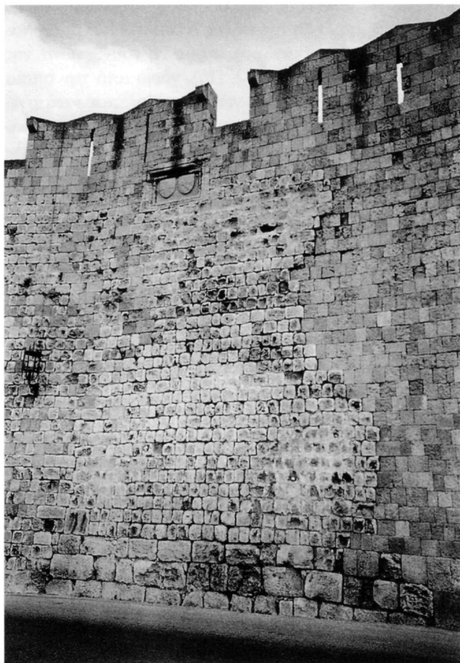
Εικ. 8. Παλαιότερη τοιχοποιία στη βάση του θαλασσινού τείχους (14ου αι.).
