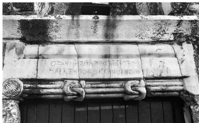
Εικ. 2. Αμφικιονίσκος από δίλοβο παράθυρο του ναού σε δεύτερη χρήση με την επιγραφή ανακαίνισής του το 1638/9.
