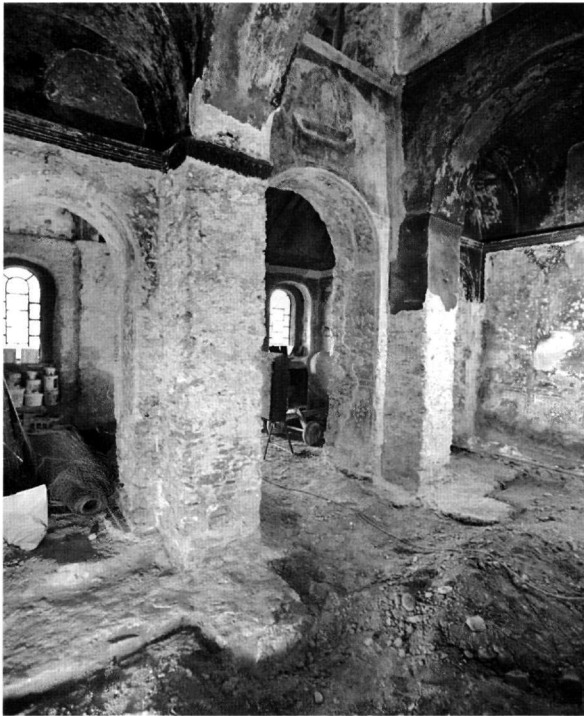
Εικ. 15. Θεμελίωση του δυτικού τοίχου του αρχικού ναού.
