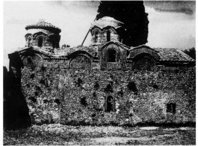
Εικ. 2. Η νότια πλευρά του ναού κατά τη διάρκεια των εργασιών αποκατάστασης (1972).
