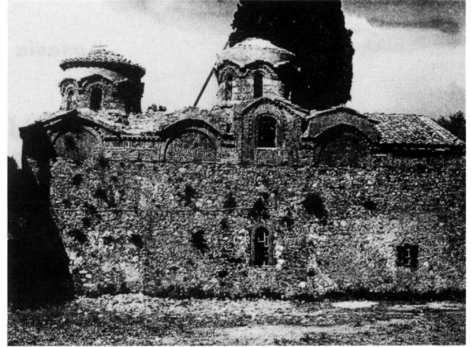
Εικ. 2. Η νότια πλευρά του ναού κατά τη διάρκεια των εργασιών αποκατάστασης (1972).
