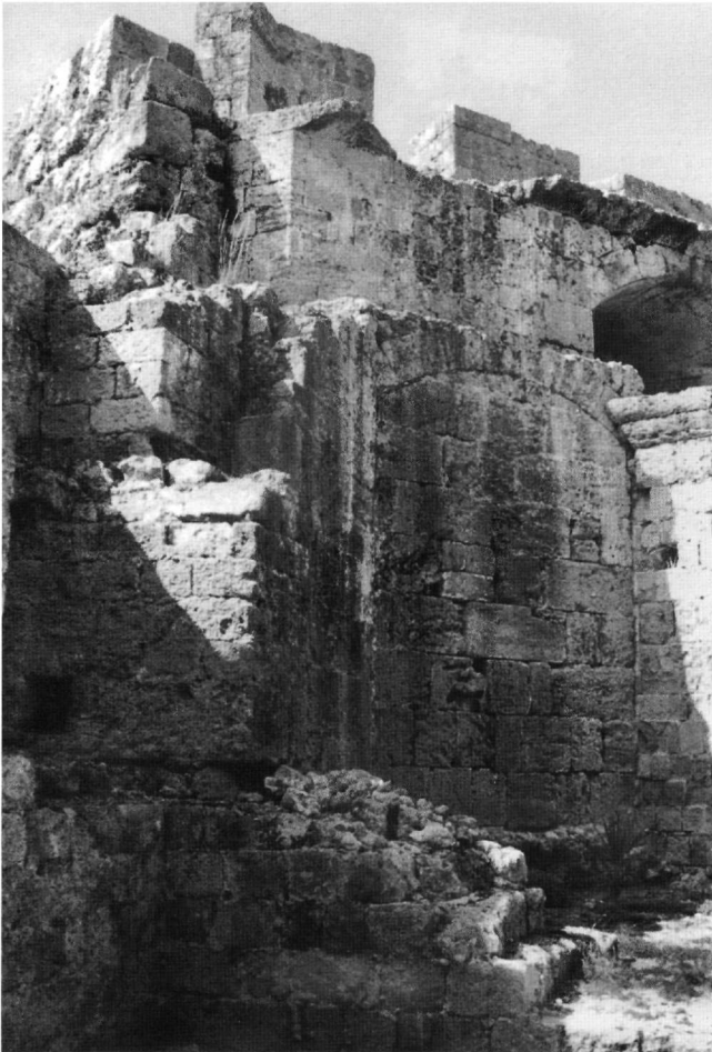
Εικ. 3. Άποψη του εσωτερικού της πύλης του παλαιού προμαχώνα πριν από τη διάνοιξή της.
