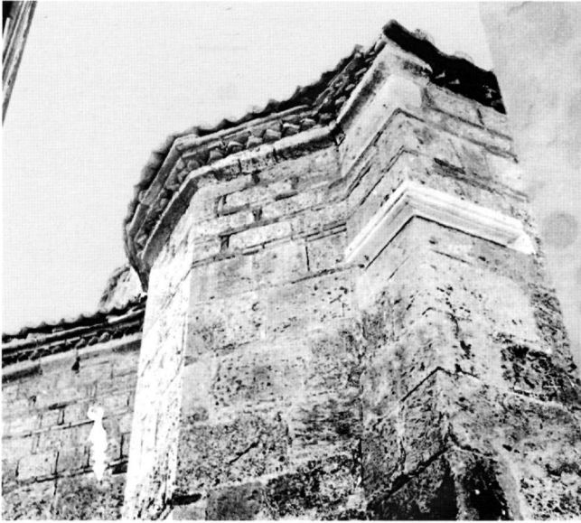
Εικ. 5. Τα λίθινα γείσα των αφίδων του ιεροῦ βήματος.
