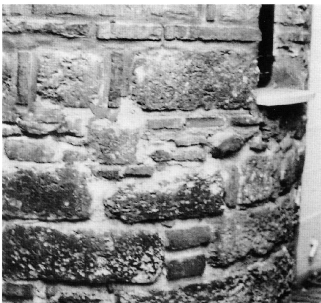
Εικ. 5. Λεπτομέρεια της τοιχοποιίας στην κόγχη του ιερού.
