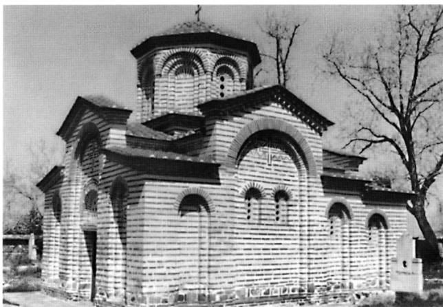
Fig. 1. L'église médiévale « Saint-Nicolas » (« St. Georges ») à Koloucha, XIe siècle, après la restauration (restaurateur l'architecte Chr. Staneva).
