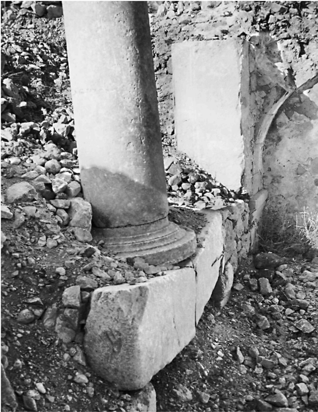
Εικ. 11. Το ρηγματωμένο ανώφλι του θυραίου ανοίγματος που συνδέει το ανατολικό με το δυτικό τμήμα του προσκτίσματος, όπως αποκαλύφθηκε μέσα στις επιχώσεις.
