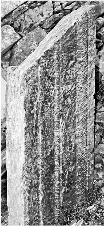
Εικ. 7. Ο νότιος κατακόρυφος σταθμός του θυραίου ανοίγματος. Όψη προς το νάρθηκα.
