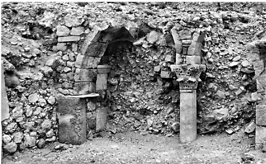
Εικ. 1. Η βορειοδυτική πλευρά του μεσαίου κλίτους της βασιλικής της Αγίας Ειρήνης, όπως αποκαλύφθηκε μετά την απομάκρυνση των πρώτων επιχώσεων.
