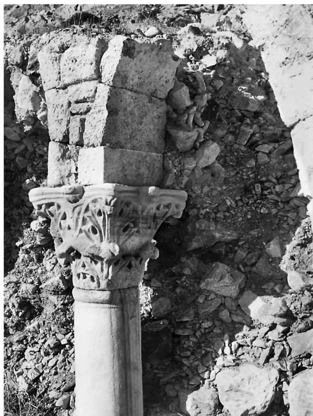
Εικ. 9. Ο κίονας Κ1 με το κιονόκρανο και τις γενέσεις των τόξων που συνέδεαν τη βόρεια κιονοστοιχία.
