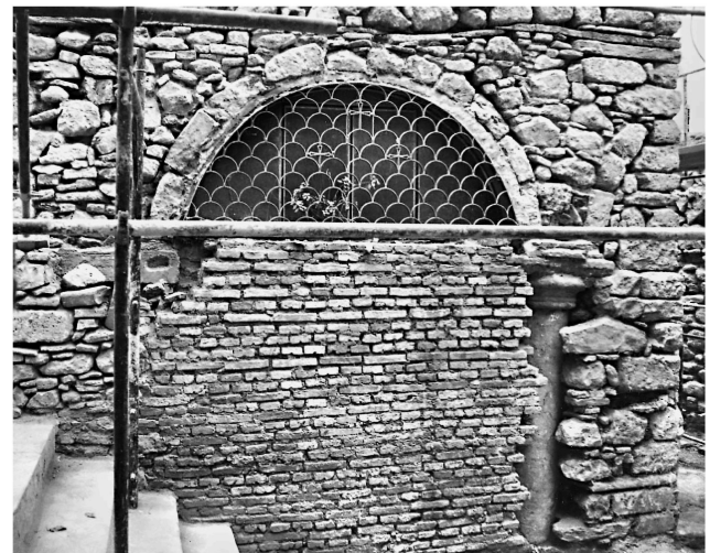
Εικ. 8. Η βόρεια πλευρά του ναού μετά την απομάκρυνση των επιχρισμάτων.
