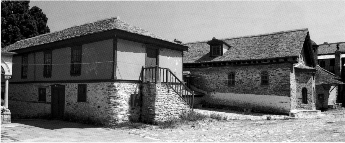
Εικ. 11. Μεγίστη Λαύρα. Οικοδομικό συγκρότημα τράπεζας. Γενική άποψη από τα βορειοδυτικά (Στ. Μαμαλούκος, Ιούνιος 2008).
