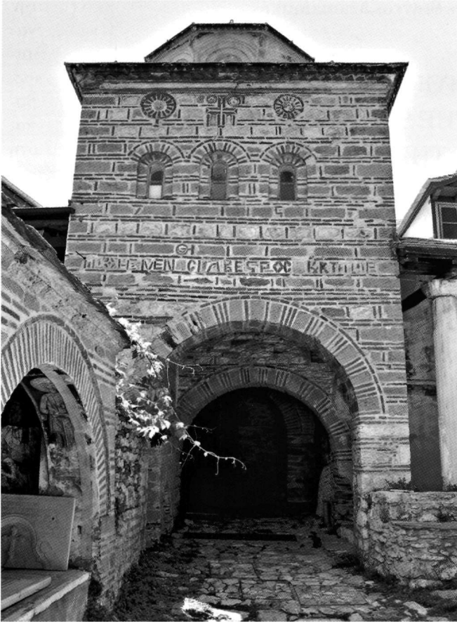
Εικ. 15. Μεγίστη Λαύρα. Παρεκκλήσιο Προδρόμου. Άποψη από τα ανατολικά (Στ. Μαμαλούκος, Ιούνιος 2008).
