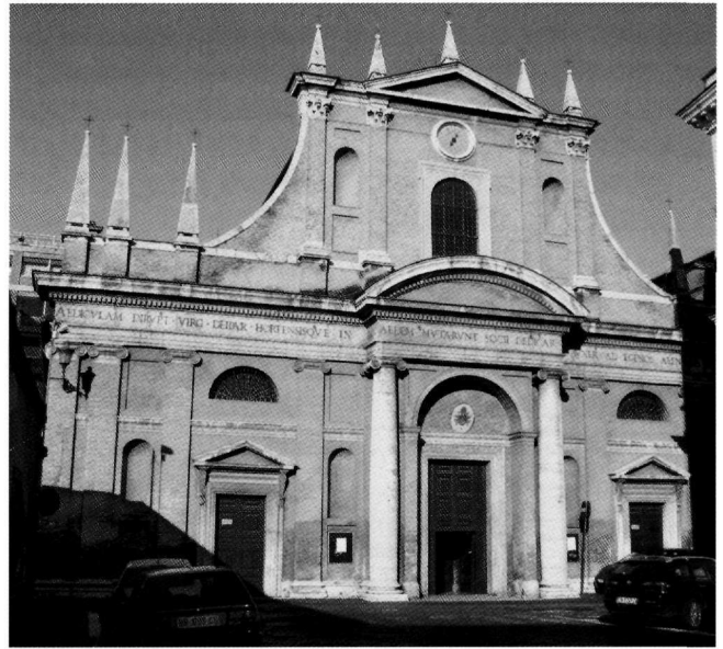
Εικ. 12. Η πρόσοψη της Santa Maria dell'Orto στη Ρώμη (1553), έργο των G. Guidetti και F. Da Volterra (R. Bernabei, Chiese di Roma , Μιλάνο 2007, 352).
