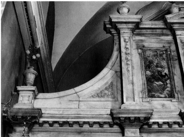
Εικ. 8. Πτερόγιο με κοίλη πλευρά (aileron), που διαμορφώνει κλιμακωτά την απόληξη του τέμπλου.
