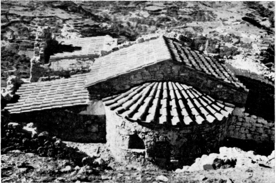
Ἄνω : Ὁψις τοῦ ναοῦ ἀπὸ ἀνατολικά, πρὸ τῶν ἐργασιῶν στερεώσεως καὶ ἀνακεραμώσεως. Κάτω : Μετὰ τὴν ἐκτέλεση τῶν ἐργασιῶν.
