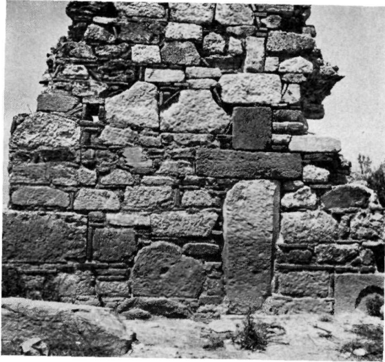
α. Δείγμα τοιχοποιίας νοτίου τοίχου.
