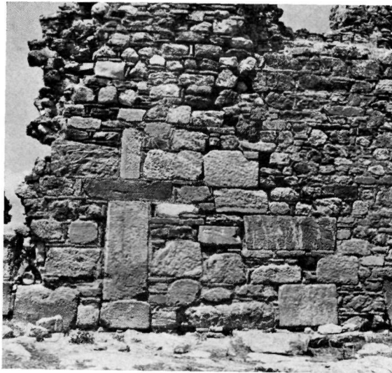
β. Δείγμα τοιχοποιίας νοτίου τοίχου.
