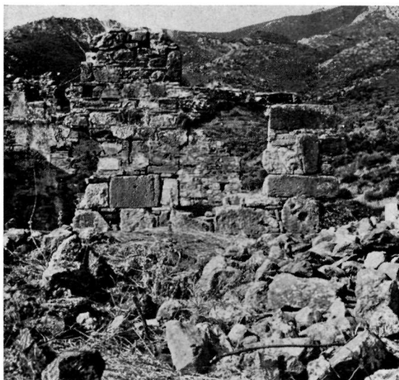
β. Δεῖγμα τοιχοποιίας βορείου τοίχου.
