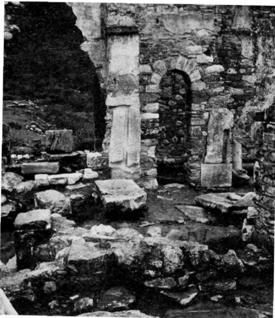
β. Αἱ ὀρθογώνιαι ἐγκοπαί, ἐνθα ἐστηρίζοντο τὰ δύο τέμπλα.
