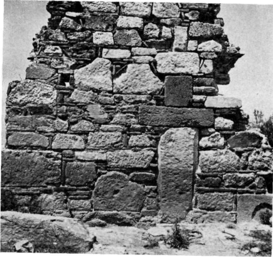
α. Δείγμα τοιχοποιίας νοτίου τείχους.
