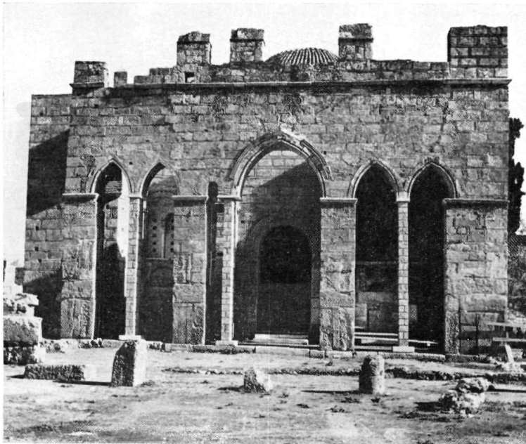
2. Δυτική ὄψις τοῦ ἔξωνάρθηκος μετὰ τὴν ἀναστήλωσιν.
