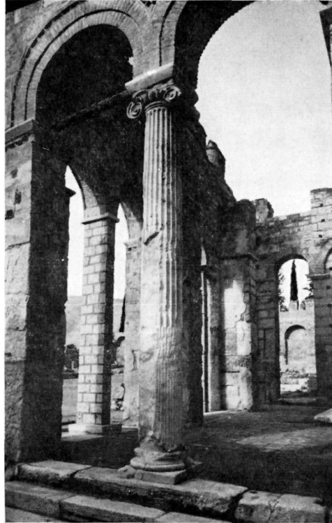
2. Δίλοβον ἄνοιγμα τῆς νοτίας πλευρᾶς τοῦ ἔξωνάρθηκος μετὰ τὴν ἀναστήλωσιν.
