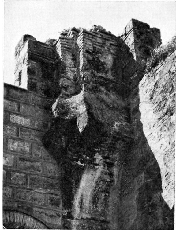
2. Ὅψις τῆς ΝΔ γωνίας τοῦ ἑξωνάρθηκος. Σφζόμεναι γεννήσεις τῶν σταυροθολίων τοῦ Ἰσογείου καὶ τοῦ ὀρόφου.
