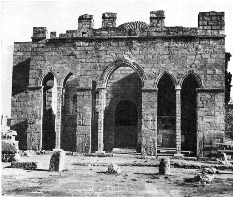
2. Δυτική ὄψις τοῦ ἔξωνάρθηκος μετὰ τὴν ἀναστήλωσιν.
