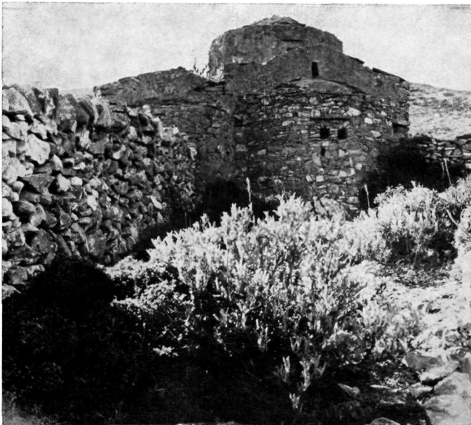
β) Ἐξωτερική ἀνατολική πλευρά.
