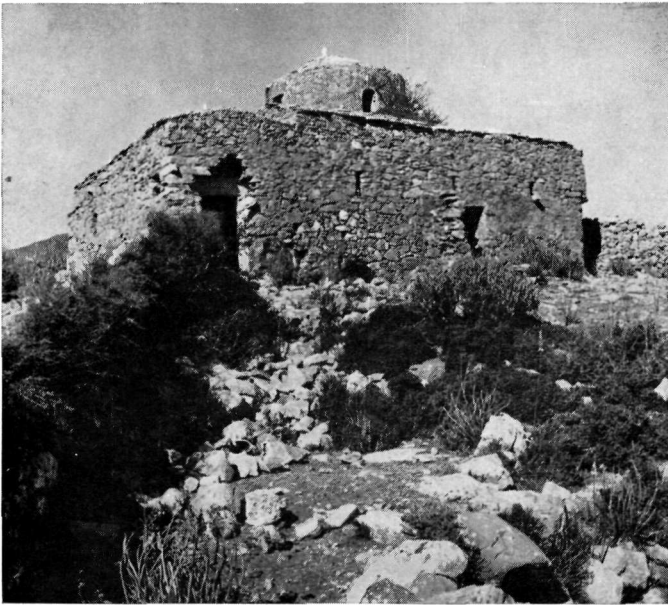
α) Ἐξωτερική νότια πλευρά.
