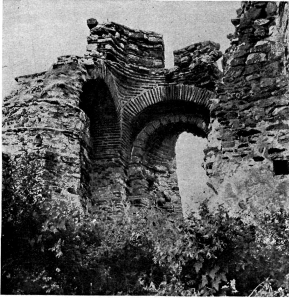
Είκ. 3. Ἐσωτερικὴ ἀποψη τῆς προθέσεως τῆς βασιλικῆς τοῦ Ἁγ. Ἀχιλλείου.
