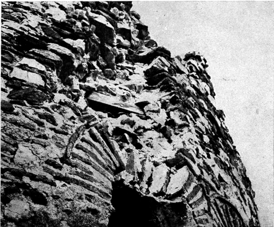
Εικ. 6. Λεπτομέρεια τῆς ἀψίδας τοῦ ἱεροῦ βήματος τῆς βασιλικῆς τοῦ Ἁγίου Ἀχιλλεῖου. Διακρίνονται οἱ κυκλικοὶ ξυλόδεσμοι στὴ μάζα τῆς τοιχοποιίας.
