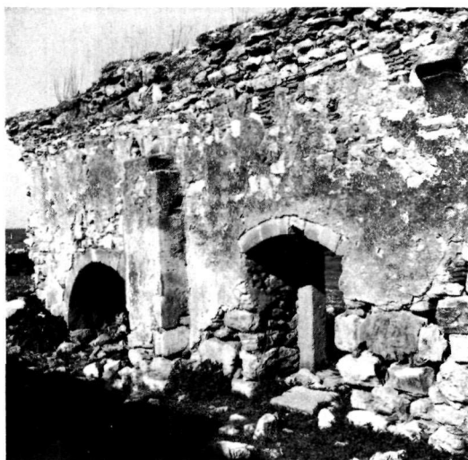
β. Ἐσωτερικὴ ὄψις Β. τοίχου. Διακρίνεται ἡ γένεσις τοῦ θόλου καὶ τοῦ σφενδονίου.
