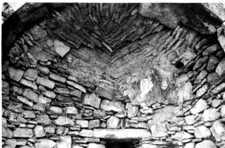
β. Κατασκευὴ τεταρτοσφαιρίου κόγχης ἱεροῦ. Ἄρχικόν στάδιον λιθοκτιστόν, μεταγενεστέρα κακότεχνος ἀνακατασκευὴ διὰ πλίνθων.
