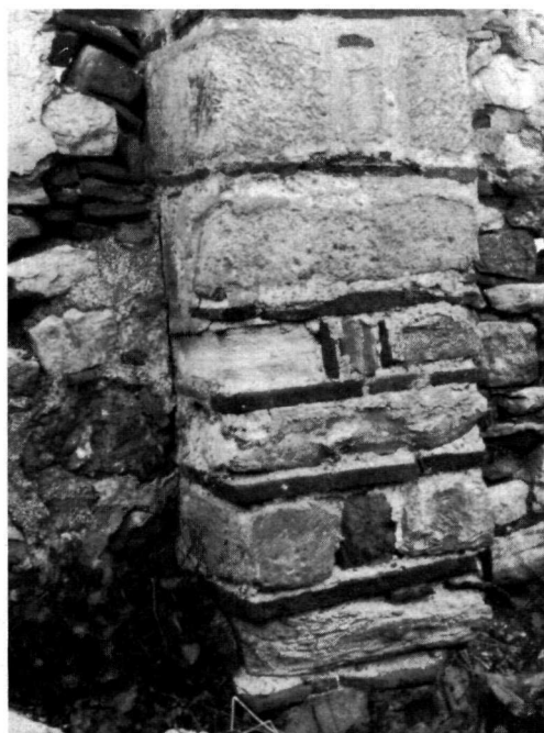
γ. Ή παραστάς τοῦ Δ. τοίχου ἔνθα καταλήγει ἢ πρὸς Β. κιονοστοιχία. Διακρίνεται ὁ διαφοριστικὸς ἄρμος μεταξύ παραστάδος - Δ. τοίχου.
