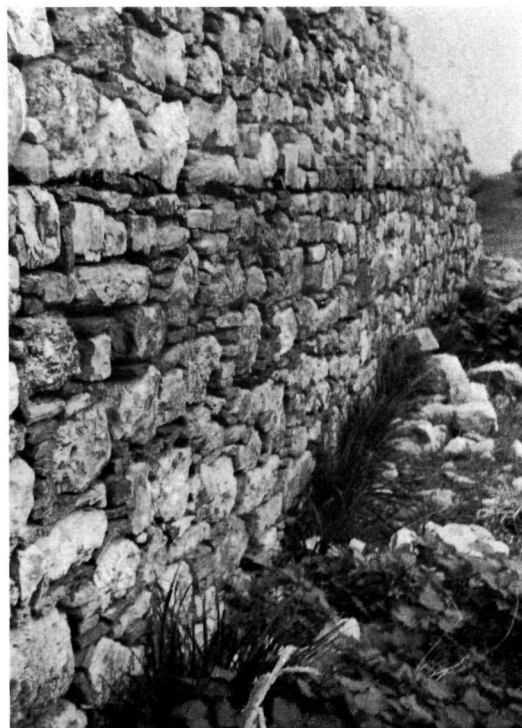
δ. Τοιχοποιία Ν. τοίχου.
