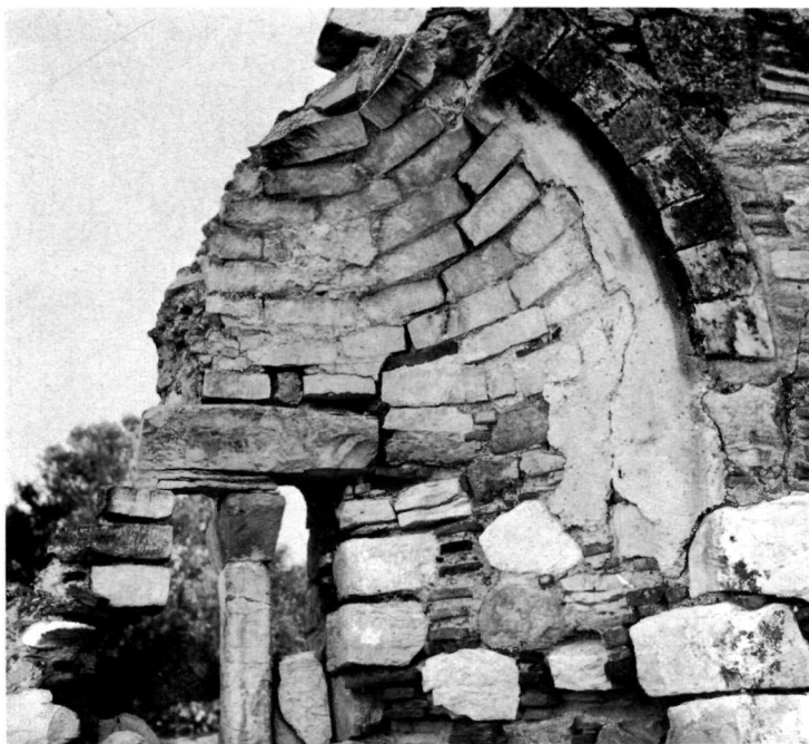
α. Άγιος Γεώργιος, Λεπτομέρεια κατασκευής τεταρτοσφαιρίου κόγχης προθέσεως (φωτογραφία 1960).
