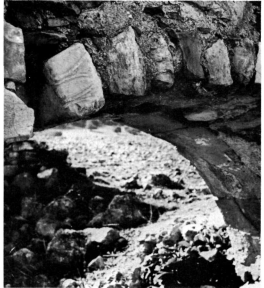
β. Ἐξωτερικὴ ὄψις τῆς πρὸς Β. κόγχης. Παλαιοχριστιανικὸν κιονόκρανον ἐντοιχισμένον ὡς θολίτης.
