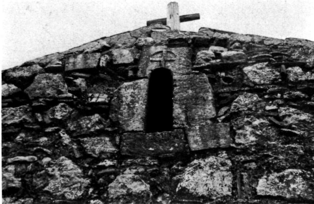
β. Λεπτομέρεια Δ. παραθύρου. Ὑλικά πλαισίου κατὰ δευτέραν χρῆσιν. Δεξιᾷ ἐντοιχισμένον πήλινον κοῖλον στοιχείον.
