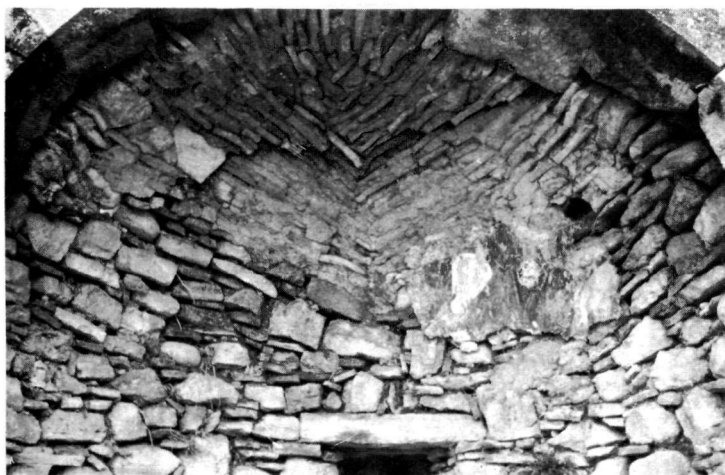
β. Κατασκευή τεταρτοσφαιρίου κόγχης ἱεροῦ. Ἄρχικόν στάδιον λιθοκτιστόν, μεταγενεστέρα κακότεχνος ἀνακατασκευή διά πλίνθων.
