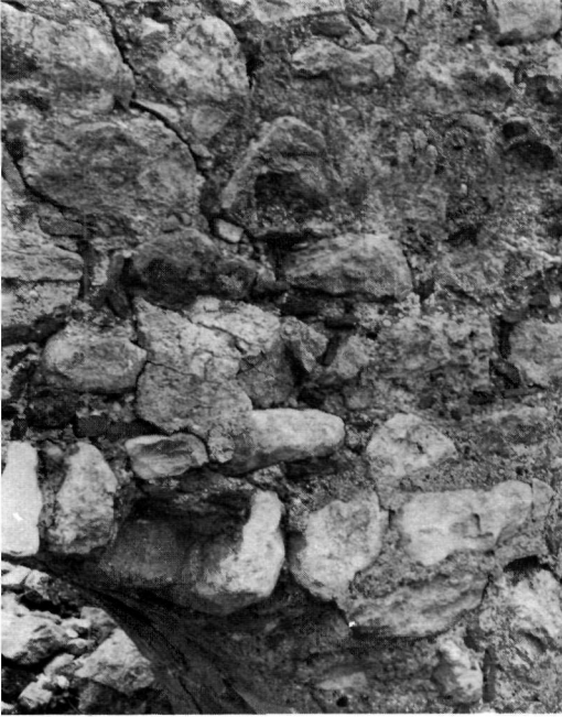
α. Ἅγιοι Ἀπόστολοι. Τοιχοποιία Β. τοίχου.
