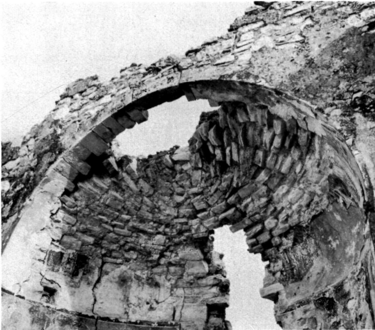
β. Λεπτομέρεια κατασκευής τεταρτοσφαιρίου κόγχης ίερού (φωτογραφία 1960).
