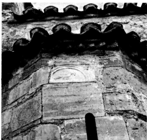
γ. Λεπτομέρειαι τοιχοποιίας καὶ στέψεως τῆς προθέσεως.
