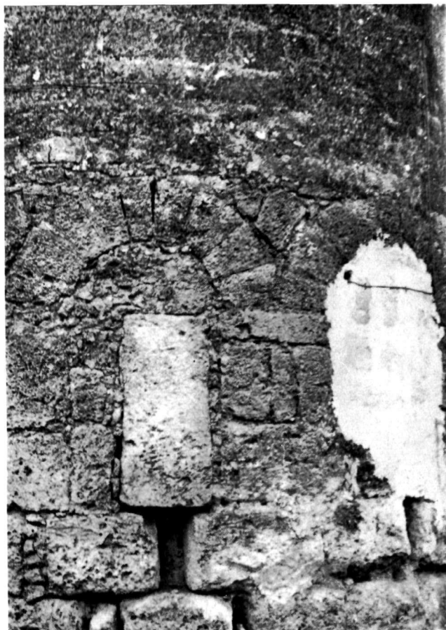
γ. Ἐξωτερικὴ ἄποψις τῆς ἀνατολικῆς κόγχης, ὅπου καὶ δείγματα διαφορετικῶν λιθοδομῶν.
