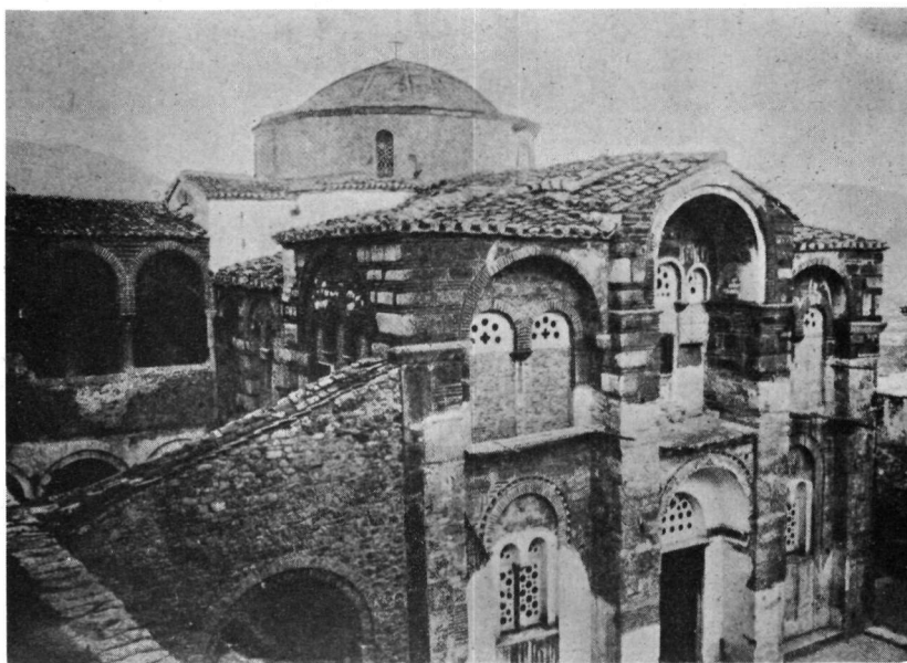
Είκ. 2. Β.Δ. άποψη του καθολικού, άμέσως μετά την κατεδάφιση του έξωνάρθηκα (Ο. Wulff).
