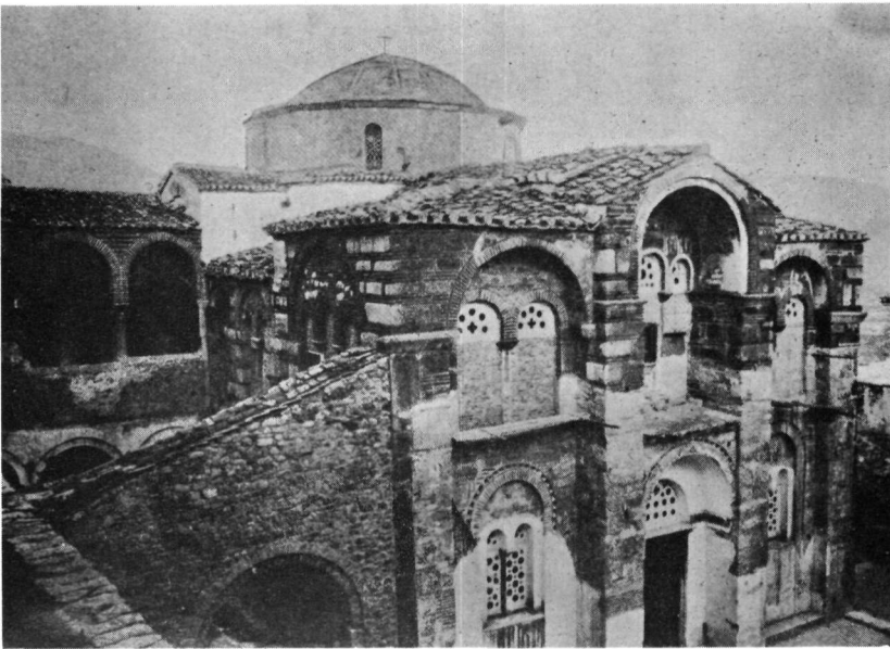
Είκ. 2. Β.Δ. άποψη του καθολικου, άμεσα μετά την κατεδάφιση του έξωνάρθηκα (O. Wulff).
