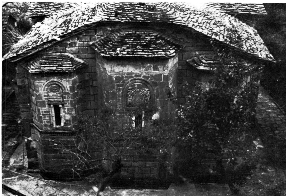
α. Όγκόλιθοι σὲ ποδαρικό παραστάδας. ρ. Ἡ λοξότμητη μαρμάρινη ζώνη καὶ ἡ ὀδοντωτὴ ταινία ἀνάμεσα στις παραστάδες. Διακρίνεται καὶ τὸ κλεισμένο παλαιότερο ἄνοιγμα. γ. Ἡ ἀνατολικὴ ὄψη τοῦ καθολικοῦ.
