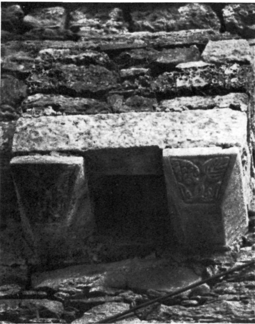
α. Λεπτομέρεια του βορεινού τόξου που πλαισιώνεται με πλίνθινα S. β. Νότιο τόξο με πάρινο κυμάτιο και δισέφυλλον. γ. Ἡ ζεματίστρα καὶ τὰ ἐπιθήματα-φουρούσια. δ. Ὁ διπλὸς σταυρὸς μετὰ τὴν χαραγμένην ἐπιγραφὴν.
