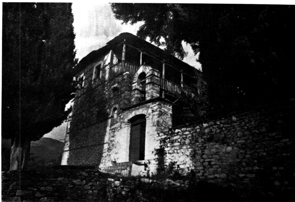
α. Ἀποψη τῆς μονῆς ἀπὸ ἀνατολικά. β. Ἡ σημερινὴ εἴσοδος τοῦ συγκροτήματος.
