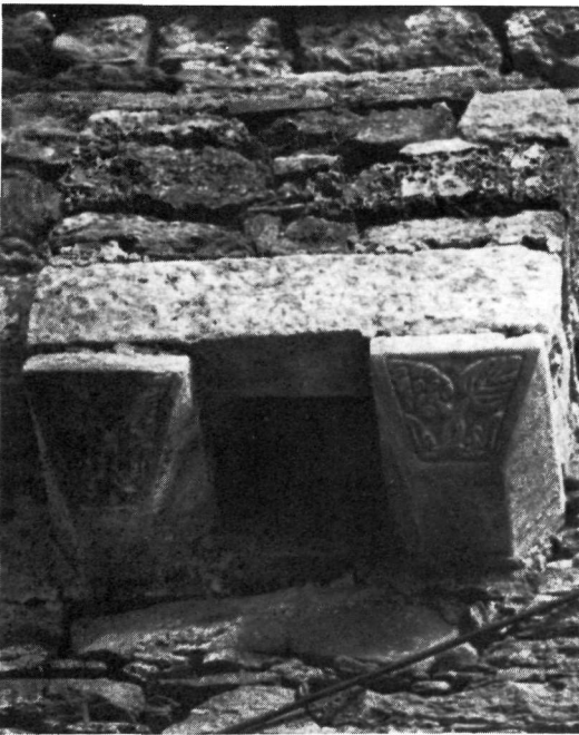
α. Λεπτομέρεια του βορεινού τόξου που πλαισιώνεται με πλίνθινα S. β. Νότιο τόξο με πάρινο κυμάτιο και δισέφυλλον. γ. Ἡ ζεματίστρα καὶ τὰ ἐπιθήματα-φουρούσια. δ. Ὁ διπλὸς σταυρὸς μετὰ τὴν χαραγμένη ἐπιγραφὴν.
