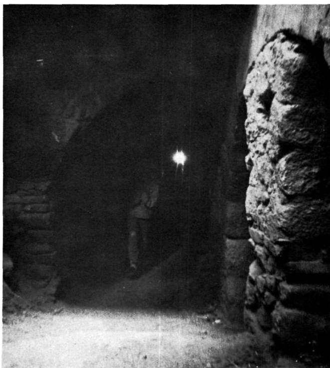
Μονή Σινᾶ. α. Ὁ γωνιακὸς ἰσόγειος χώρος τῆς Σκευοφυλακείας μετ' ἐπιπέδου τῆς πρώτης ἀψίδας τῆς Ἰουστινιάνειας τοξοστοιχίας (Δεκ. 1971). β. Ἡ πρώτη ἀψίδα τῆς Ἰουστινιάνειας τοξοστοιχίας καὶ ἡ ἀρχὴ τοῦ διαδρόμου πρὸς τὰ Δ., μετὰ τὴ μερικὴ ἀποχωμάτωση (Φεβρ. 1972).
