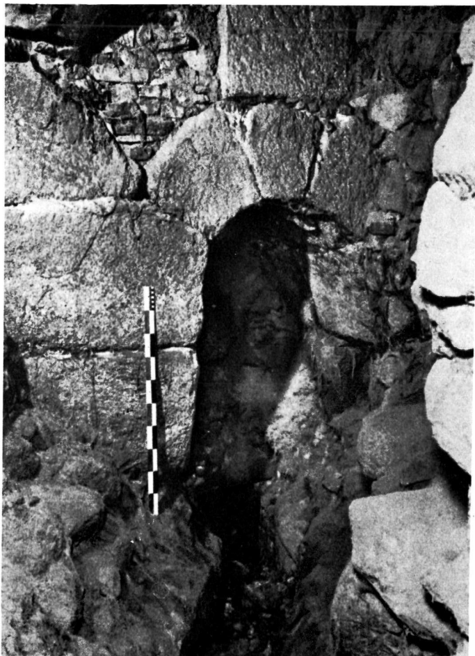
Μονή Σινᾶ. α. Ὁ ἀψιδωτὸς ἀγωγὸς ἀπορροφῆς ὀμβρίων τοῦ ΒΔ. Ἰουστινιάνειου τείχους. β. Ἀψιδωτὸ ἄνοιγμα τῆς ἐσωτερικῆς πλευρᾶς τοῦ ΝΔ. Ἰουστινιάνειου τείχους (φωτογραφιῆς Forsyth).
