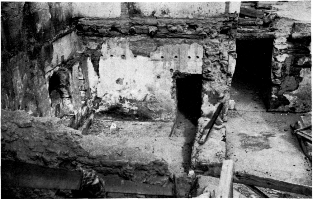
Μονή Σινᾶ. α. Δυὸ χῶροι τοῦ ὀρόφου τῆς Σκευοφυλακείας, σὲ ἐπαφή μετὰ τὴν ἐσωτερικὴ πλευρὰ τοῦ ΒΑ. Ἰουστινιάνειου τείχους (Φεβρ. 1972). β. Τμήμα τοῦ ὀρόφου τῆς Σκευοφυλακείας μετὰ τὶς εἰσόδους στὶς δύο ἐπιμήκεις, πρὸς τὰ Δ. ἀποθήκες (Φεβρ. 1972).
