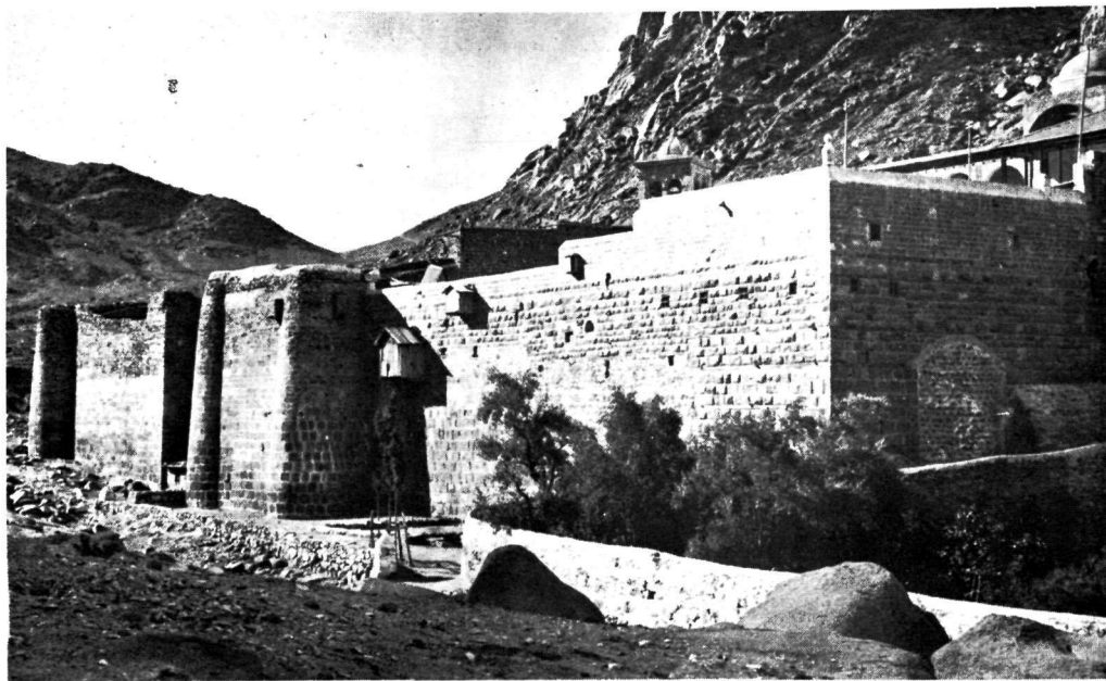
Μονη Σινᾶ. α. Ἡ περιοχή ἀνάμεσα στην ἐκκλησίαν τῆς Θεοτόκου καὶ τὸ ΒΑ. Ἰουστινιάνειο τείχος (Φεβρ. 1972). β. Ἡ ΒΑ. καὶ τμήμα τῆς ΒΔ. πλευρᾶς τοῦ Ἰουστινιάνειου τείχους (πρὶν ἀπὸ τὴν πυρκαγιά).
