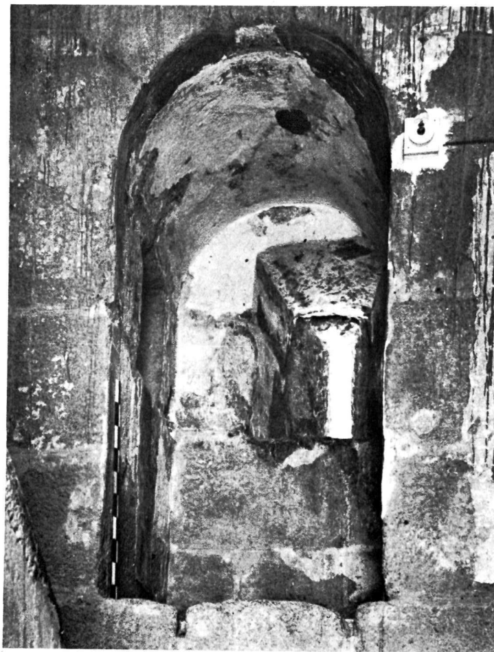
Μονή Σινᾶ. α. Ὁ ἀψιδωτὸς ἀγωγὸς ἀπορροφῆς ὀμβρίων τοῦ ΒΔ. Ἰουστινιάνειου τείχους. β. Ἀψιδωτὸ ἄνοιγμα τῆς ἐσωτερικῆς πλευρᾶς τοῦ ΝΔ. Ἰουστινιάνειου τείχους (φωτογραφιῆς Forsyth).
