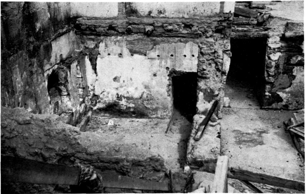
Μονή Σινᾶ. α. Δυὸ χώροι τοῦ ὀρόφου τῆς Σκευοφυλακείας, σὲ ἐπαφή μετὰ τὴν ἐσωτερικὴ πλευρὰ τοῦ ΒΑ. Ἰουστινιάνειου τείχους (Φεβρ. 1972). β. Τμήμα τοῦ ὀρόφου τῆς Σκευοφυλακείας μετὰ τὶς εἰσόδους στὶς δύο ἐπιμήκεις, πρὸς τὰ Δ. ἀποθήκες (Φεβρ. 1972).
