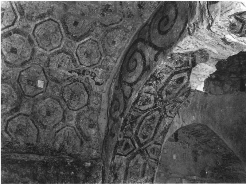
Είκ. 22. Ἀποψη τῶν τοιχογραφιῶν στήν καμάρα καί τό σφενδόνιο, νότια πλευρά.
