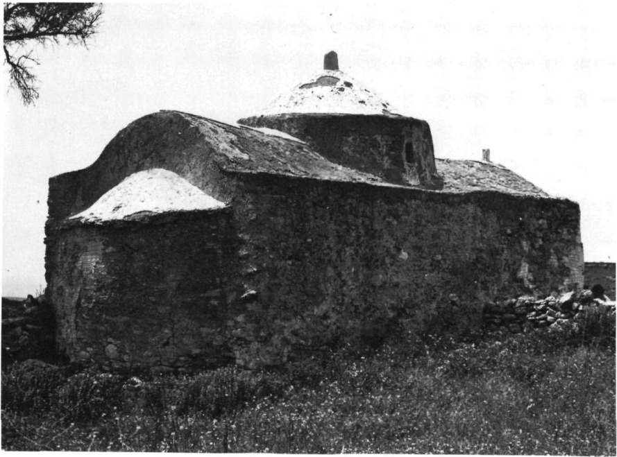
Είκ. 1-2. Ὁ ναός τοῦ Ἁγίου Ἰωάννη τοῦ Θεολόγου στ' Ἀδησαροῦ. Ἐποψη ἀπὸ νοτιοδυτικά καὶ ἀπὸ βορειοανατολικά.
