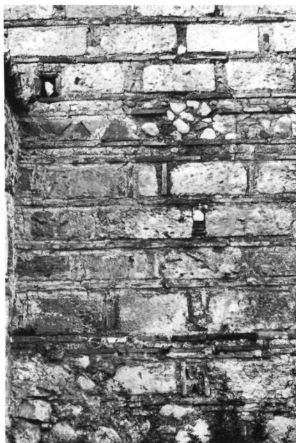
Είκ. 17. "Άγιος Ίωάννης Παλιού Λιγουριού. Τμήμα τού νότιου τοίχου τού κυρίως ναού.
