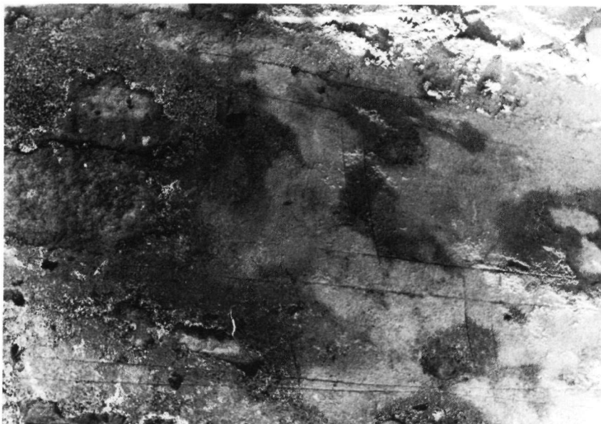
Εικ. 4. Ἐπισκοπή Ἱεράπετρας. Ἅγιος Γεώργιος-Ἅγιος Χαράλαμπος. Δυτική ὄψη βόρειου διαμερίσματος. Χαράγματα μέ μυστήρι στό κονίαμα.
