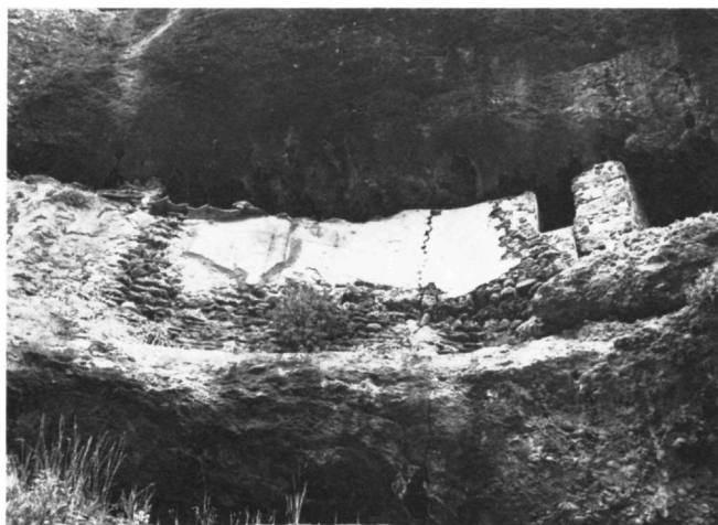
Είκ. 1. 'Αι-Γιαννάκης Ζούπενας. 'Η έξωτερική πλευρά του ανατολικού τοίχου
