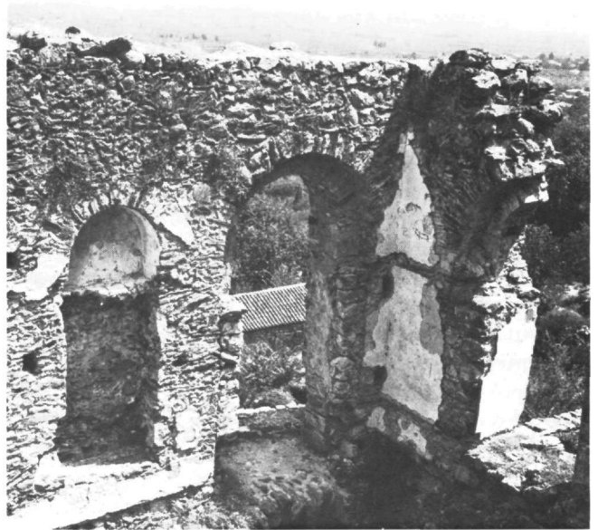
Είκ. 21. Σπίτι του Λάσκαρη. Τοξύλλια και φουρούσια στη νότια γωνία του ήλιακού (φωτ. 1973)
