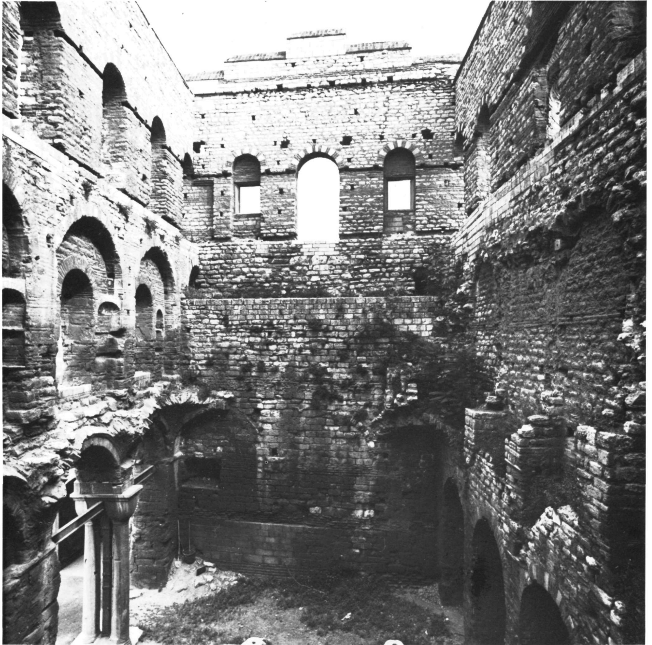
Εικ. 31. Τεκφούρ Σεράι Κωνσταντινουπόλεως. Τό έσωτερικό
