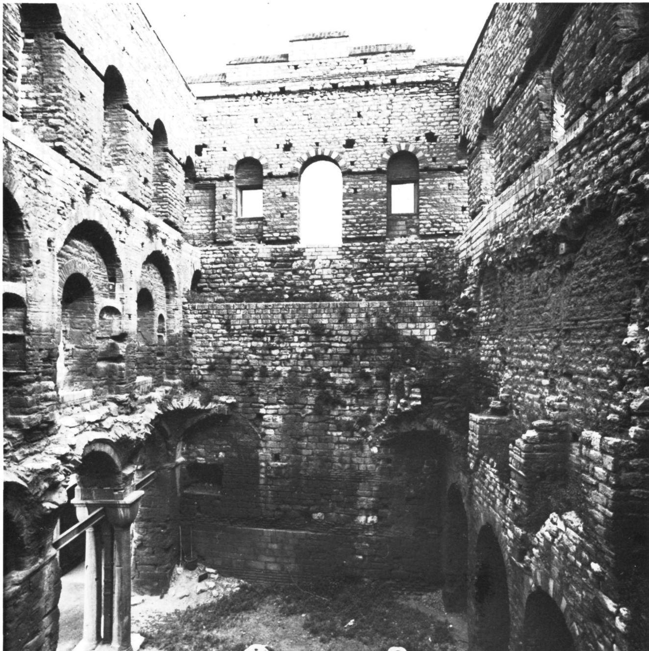
Εικ. 31. Τεκφούρ Σεράι Κωνσταντινουπόλεως. Τό έσωτερικό
