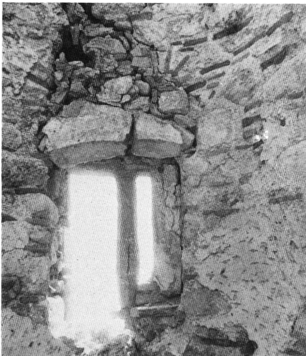
Εικ. 16. Το συγκρότημα του ναού, όπως σώζεται σήμερα. Εικ. 17. Το παράθυρο της τρίπλευρης αψίδας εσωτερικά. Διακρίνονται τα τόξα του δίλοβου παλαιότερου παραθύρου. Εικ. 18. Η πλίνθινη διακόσμηση του τόξου της νότιας θύρας του ναού. Εικ. 19. Αποκατάσταση της βυζαντινής φάσης του ναού.
