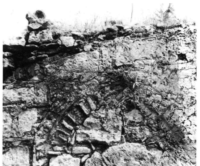
Εικ. 16. Το συγκρότημα του ναού, όπως σώζεται σήμερα. Εικ. 17. Το παράθυρο της τρίπλευρης αψίδας εσωτερικά. Διακρίνονται τα τόξα του δίλοβου παλαιότερου παραθύρου. Εικ. 18. Η πλίνθινη διακόσμηση του τόξου της νότιας θύρας του ναού. Εικ. 19. Αποκατάσταση της βυζαντινής φάσης του ναού.
