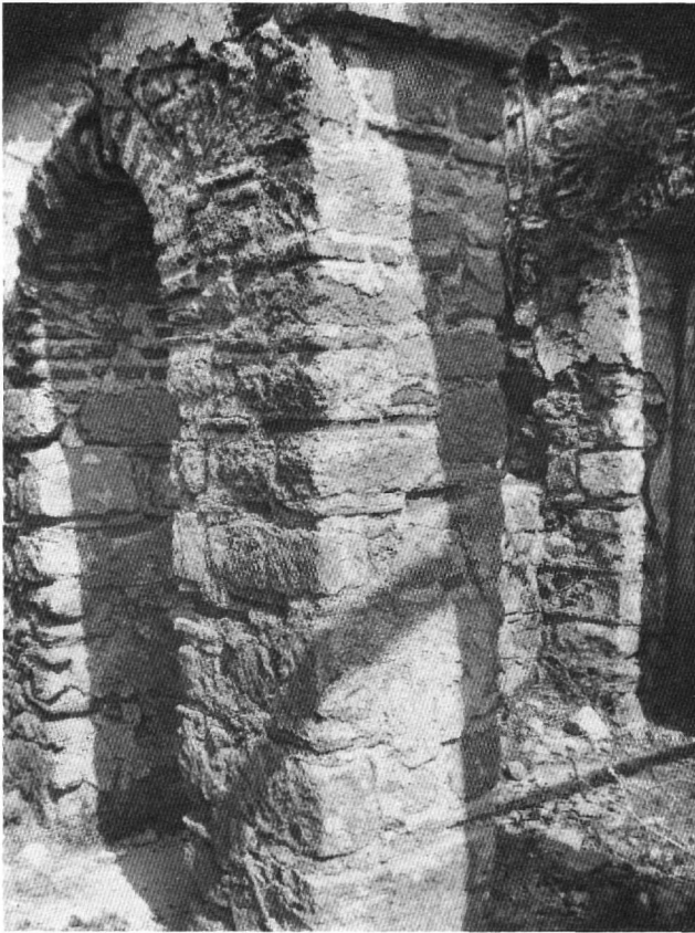
Εικ. 13. Ο νότιος τοίχος. Ψηλότερα η τοιχοδομή με υλικό σε δεύτερη χρήση. Χαμηλά στη βάση υπολείμματα της αρχικής τοιχοποιίας.
