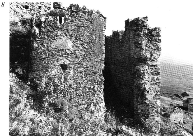
Εικ. 8. Κτίριο 3. Είσοδοι ανωγίου-κατωγίου.
