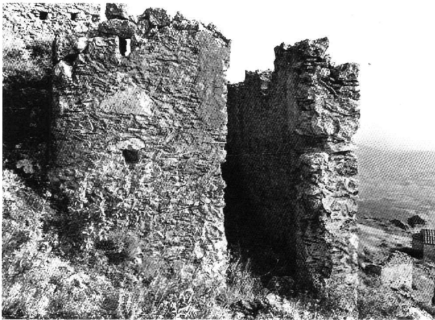
Εικ. 8. Κτίριο 3. Είσοδοι ανωγίου-κατωγίου.
