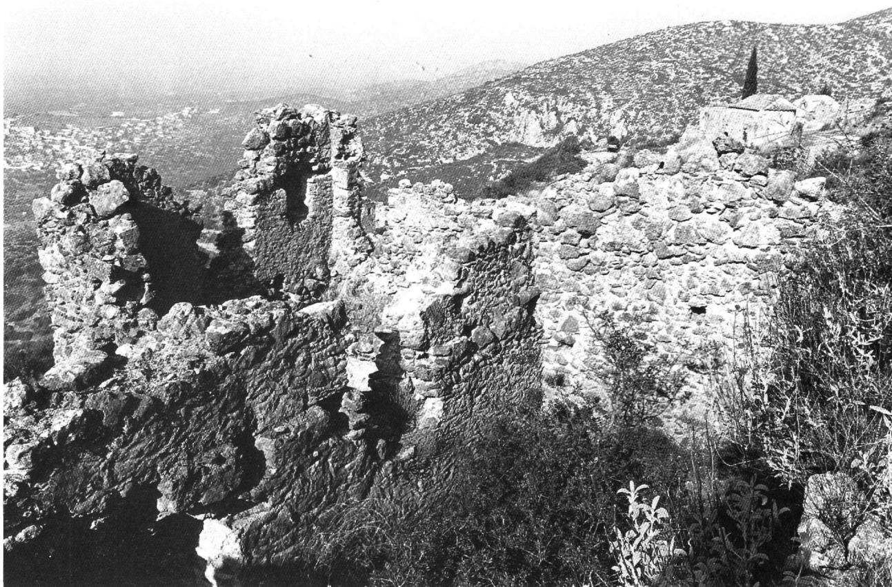
Εικ. 25. Κτίριο 13. Άποψη προς τα βορειοδυτικά.
