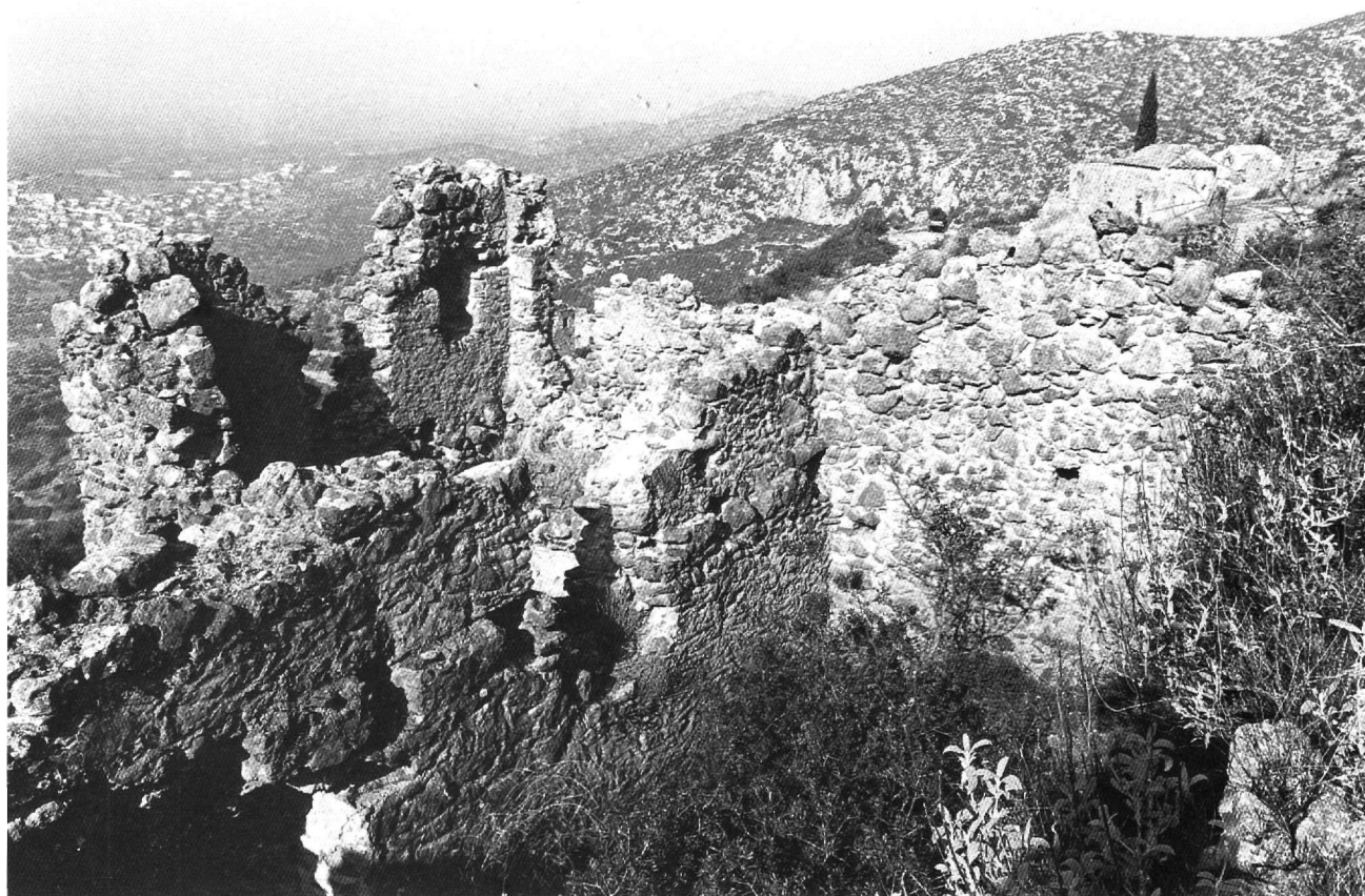
Εικ. 25. Κτίριο 13. Άποψη προς τα βορειοδυτικά.
