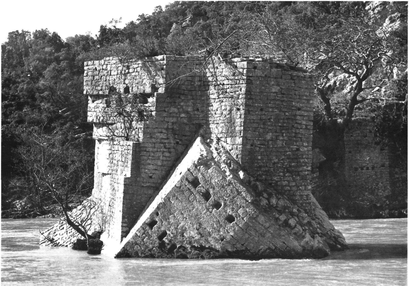
Εικ. 4. Ουζντίνα Θεσπρωτίας. Γέφυρα του 1628 στη θέση αρχαίας.
