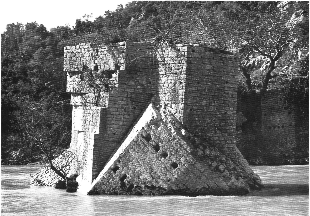
Εικ. 4. Ουζντινά Θεσπρωτίας. Γέφυρα του 1628 στη θέση αρχαίας.
