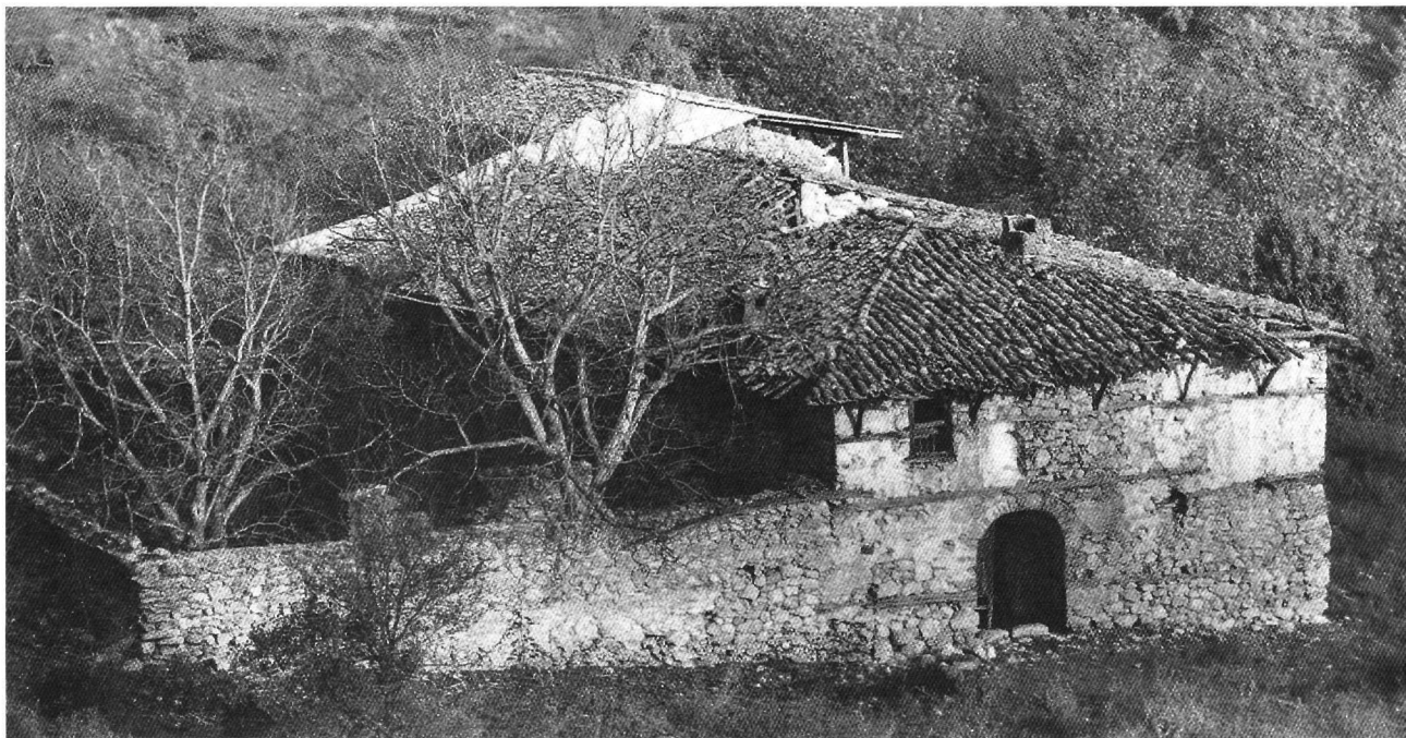
1. Γενική άποψη της μονής Τορνικίου Γρεβενών από δυτικά.
