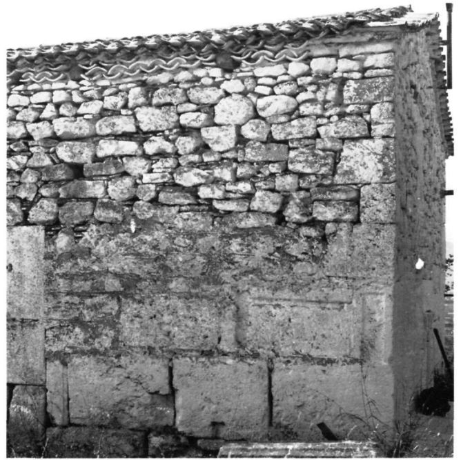
Είκ. 3. Ραχιώτισσα Φλιοῦντος. Τμήμα τῆς βορείας πλευρᾶς τοῦ μνημείου μέ ἔνδειξη τῆς ἀρχικῆς καὶ τῆς νεωτέρας τοιχοποιίας τῆς.
