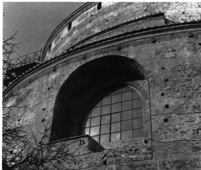
Εικ. 26. Η βάση του νότιου παραθύρου μετά την πρόσκαιρη αφαίρεση της εξωτερικής επίχωσης.
