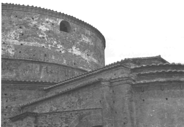
Εικ. 20. Η οδοντωτή ταινία στη νότια πλευρά της δικλινούς στέγης του Ιερού, στη διάρκεια των εργασιών συντήρησης. Εικ. 21. Η διάταξη των στεγών στο Ιερό και η νότια αντηρίδα μετά τις εργασίες.
