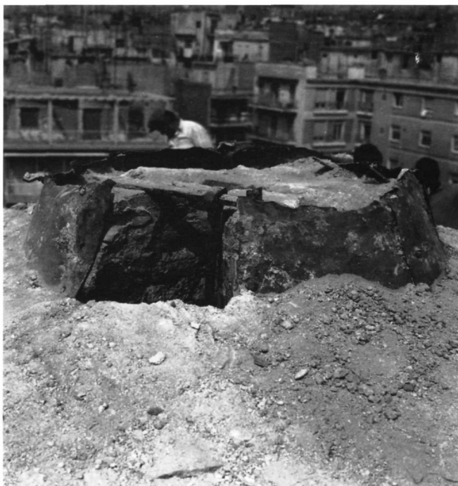
Εικ. 14. Εξωτερικό κορύφωμα του τρούλλου και η μεταλλική ανάρτηση.
