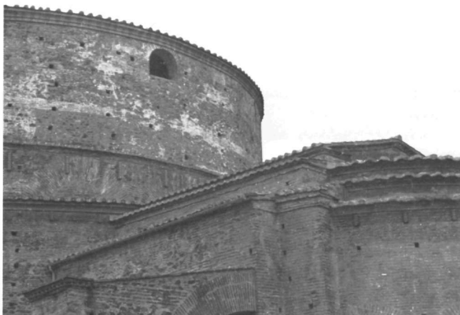
Εικ. 20. Η οδοντωτή ταινία στη νότια πλευρά της δικλινούς στέγης του Ιερού, στη διάρκεια των εργασιών συντήρησης. Εικ. 21. Η διάταξη των στεγών στο Ιερό και η νότια αντηρίδα μετά τις εργασίες.
