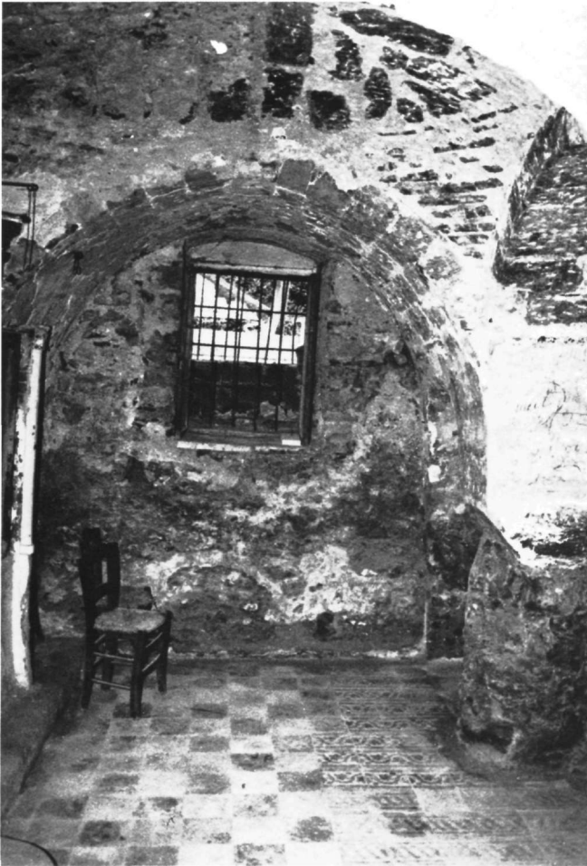
Εικ. 5. Καλαμάτα. Άγιος Χαράλαμπος. Άποψη στο εσωτερικό του κάτω ορόφου μετά την απομάκρυνση των επιχρισμάτων. Διακρίνονται οι λαξευτοί θολίτες, η ασπίδα με τις νευρώσεις και ο ένας από τους κίονες.
