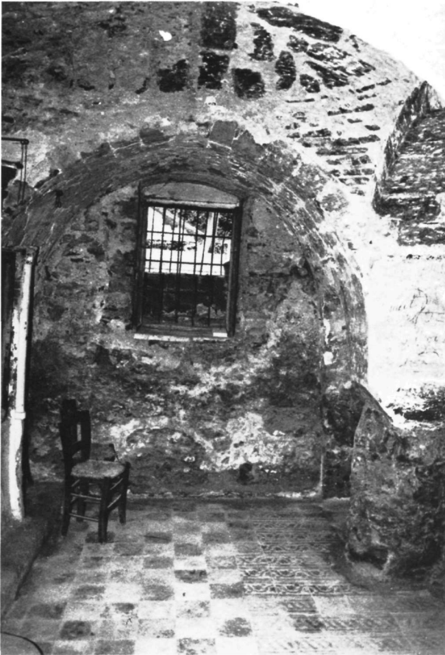
Εικ. 5. Καλαμάτα. Άγιος Χαράλαμπος. Άποψη στο εσωτερικό του κάτω ορόφου μετά την απομάκρυνση των επιχρισμάτων. Διακρίνονται οι λαξευτοί θολίτες, η ασπίδα με τις νευρώσεις και ο ένας από τους κίονες.
